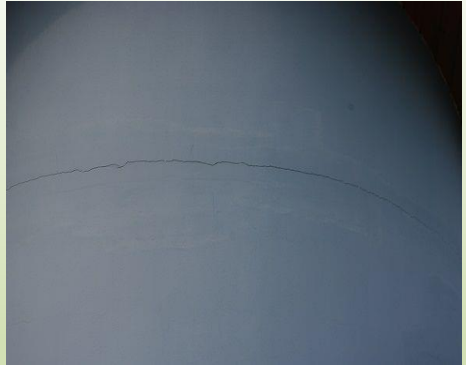
Vízszintes repedés munkahézagnál
