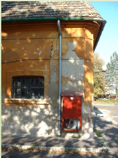
Repedés a tető oldalnyomásából
