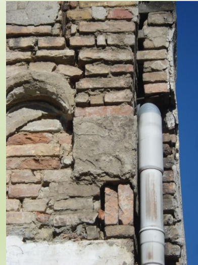
Repedés ázásból fagyásból
