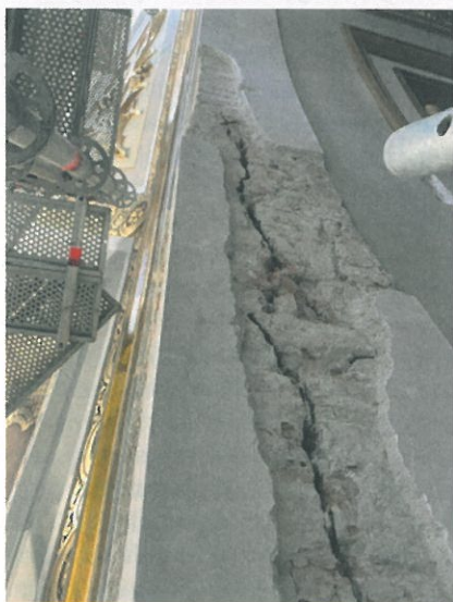
A feltárt kritikus repedések a bazilika padlószintjétől mért +20 m magasságban
