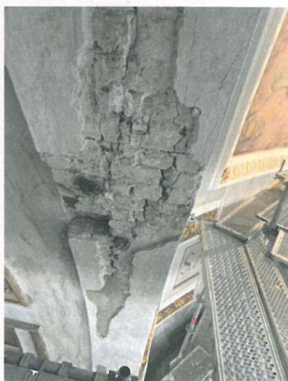
A feltárt kritikus repedések a bazilika padlószintjétől mért +20 m magasságban
