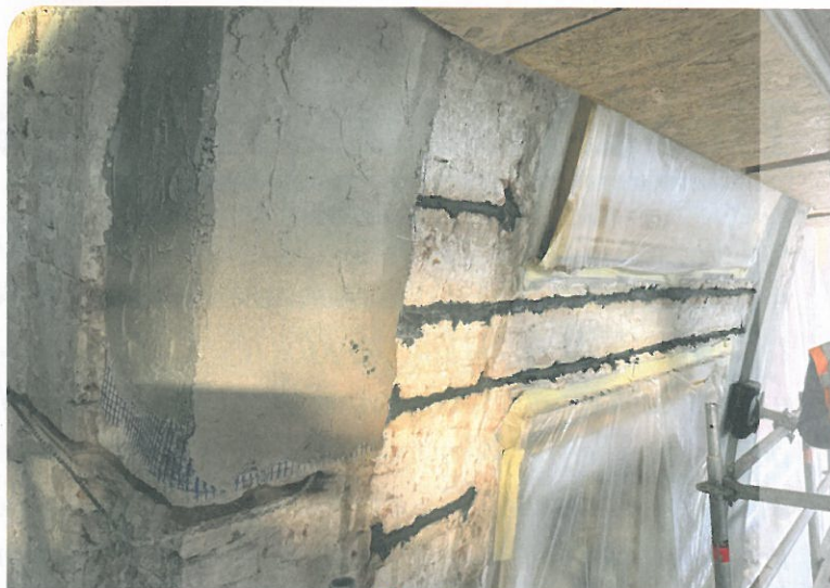
A stabilizálás kialakítása
